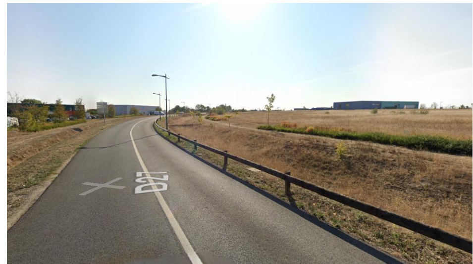
Figure 33 - Voiries de desserte de la ZA de la Louveterie (Source : Google Maps)
